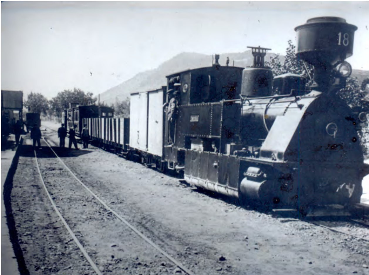
← Un tren mixt encapçalat per la locomotora núm. 18 a l'estació de Balsareny (c. 1910). ARXIU SALMERÓN
